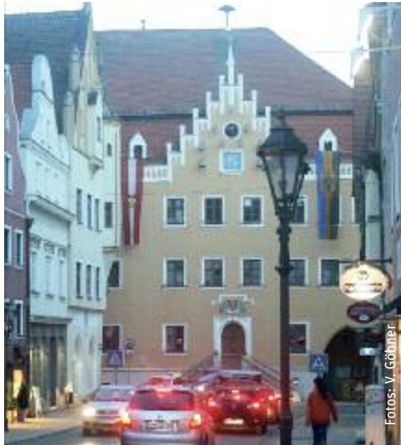
Schon im Mittelalter rezyklierten die Donauwörther Baustoffe: Das Rathaus ist zum Teil mit alten Steinen der Mangoldburg gebaut.
