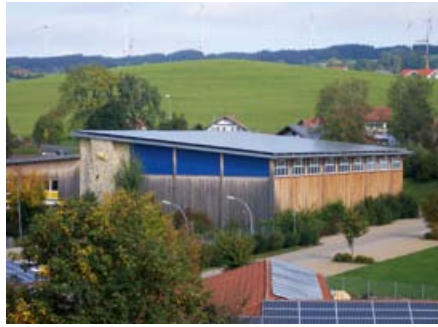
Solarenergie und Windkraftträder in Wildpoldsried
