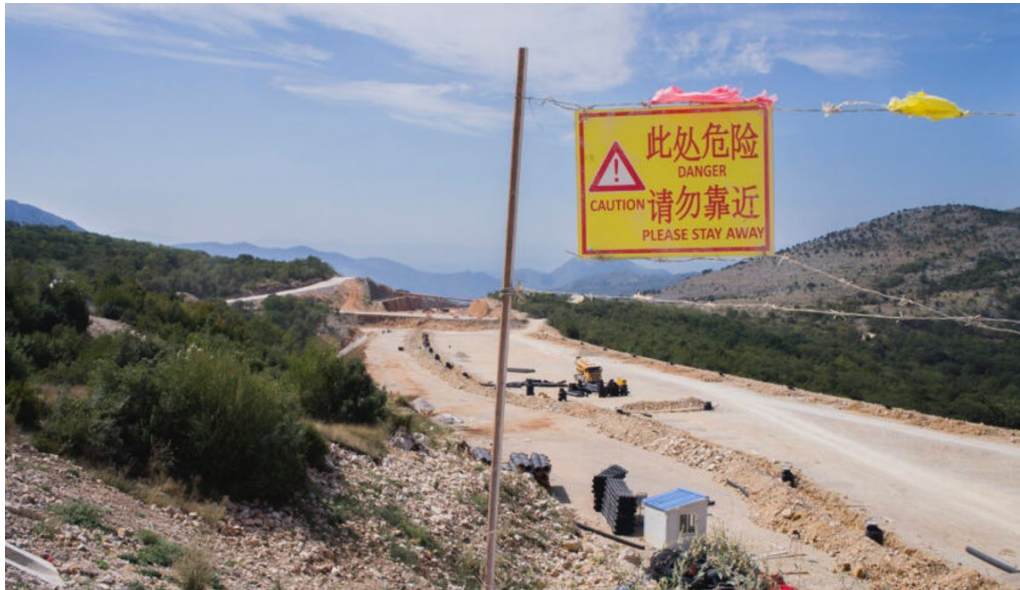
Abbildung 5: Verkehrsinfrastruktur als einflusspolitisches Instrument: Die Autobahn Bar-Boljare in Montenegro, gebaut von Chinas Road and Bridge Corporation.
